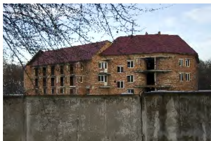
Незавершене будівництво готелю
