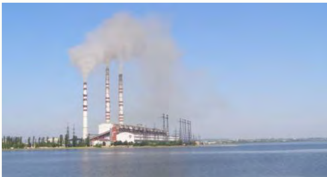
Бурштинська ТЕС (ПАТ «ДТЕК Західенерго»)
