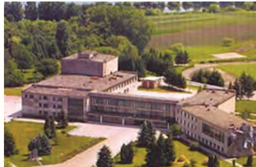
Будівля Палацу культури
